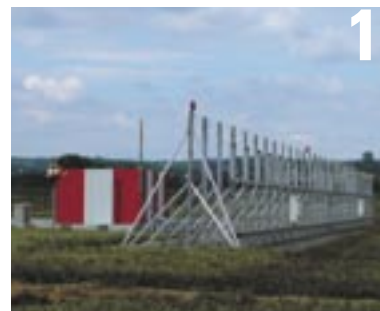
1 Le radio Alignement de piste (Localiser) permet aux avions de s'aligner sur l'axe de la piste.
