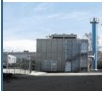
La centrale de cogénération
